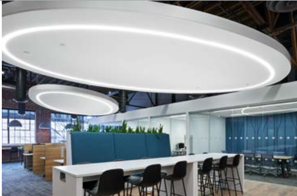
Sistema de cielo acústico AcoustiBuilt: instalación en la nube; In8Bio, Birmingham, Alabama
