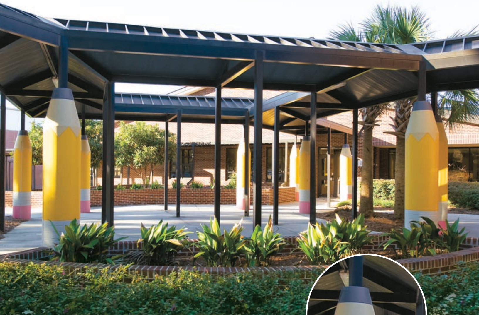
Cubiertas de columna temáticas de FRP; St. Helena Elementary School, Beaufort, SC; Goforth Brown & Associates
