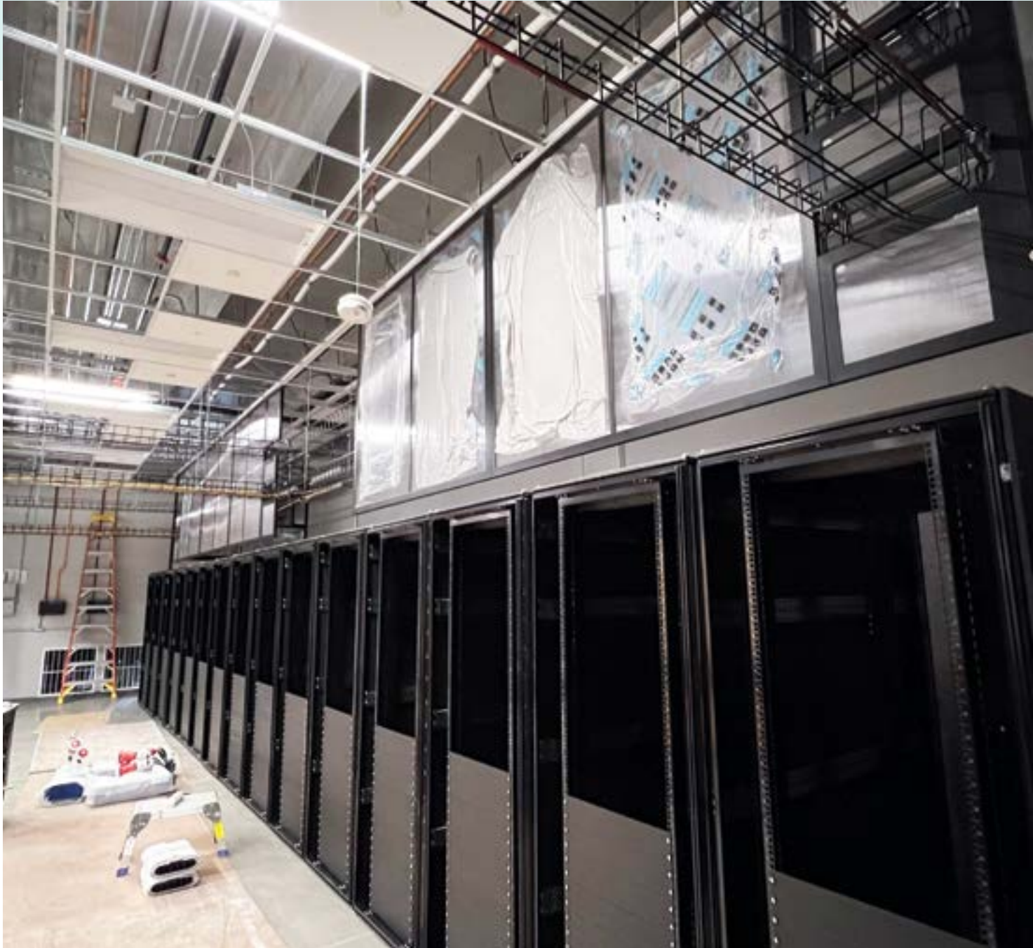
▲ Sistema de suspensión estructural DynaMax® con sistema de contención de aire integrado de Subzero Engineering
