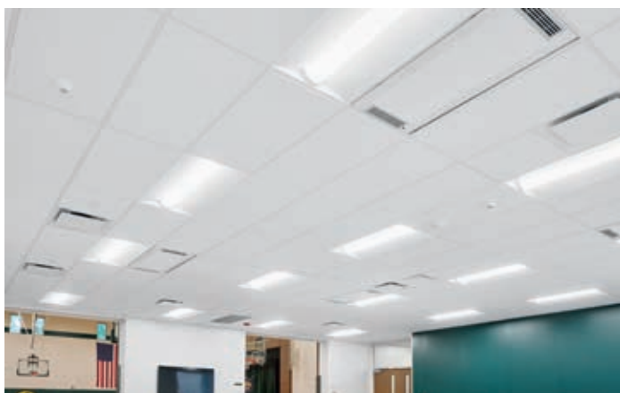
Sistema de purificação de ar VIDASHIELD UV24™ com forros de fibra mineral Armstrong CleanAssure
