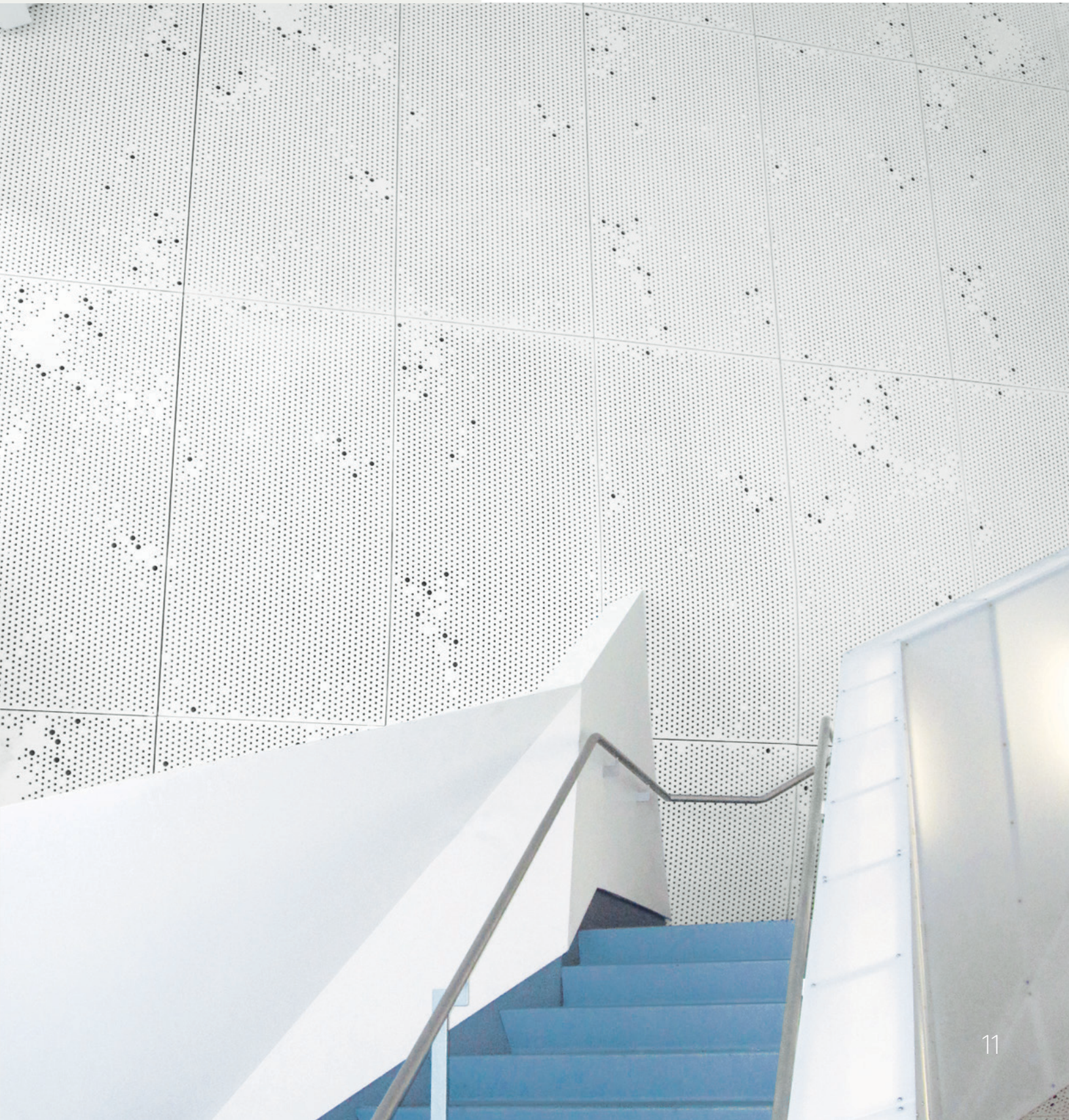
Panneaux muraux en GRV perforés aléatoirement, The Cooper Union, New York, NY; Morphosis
