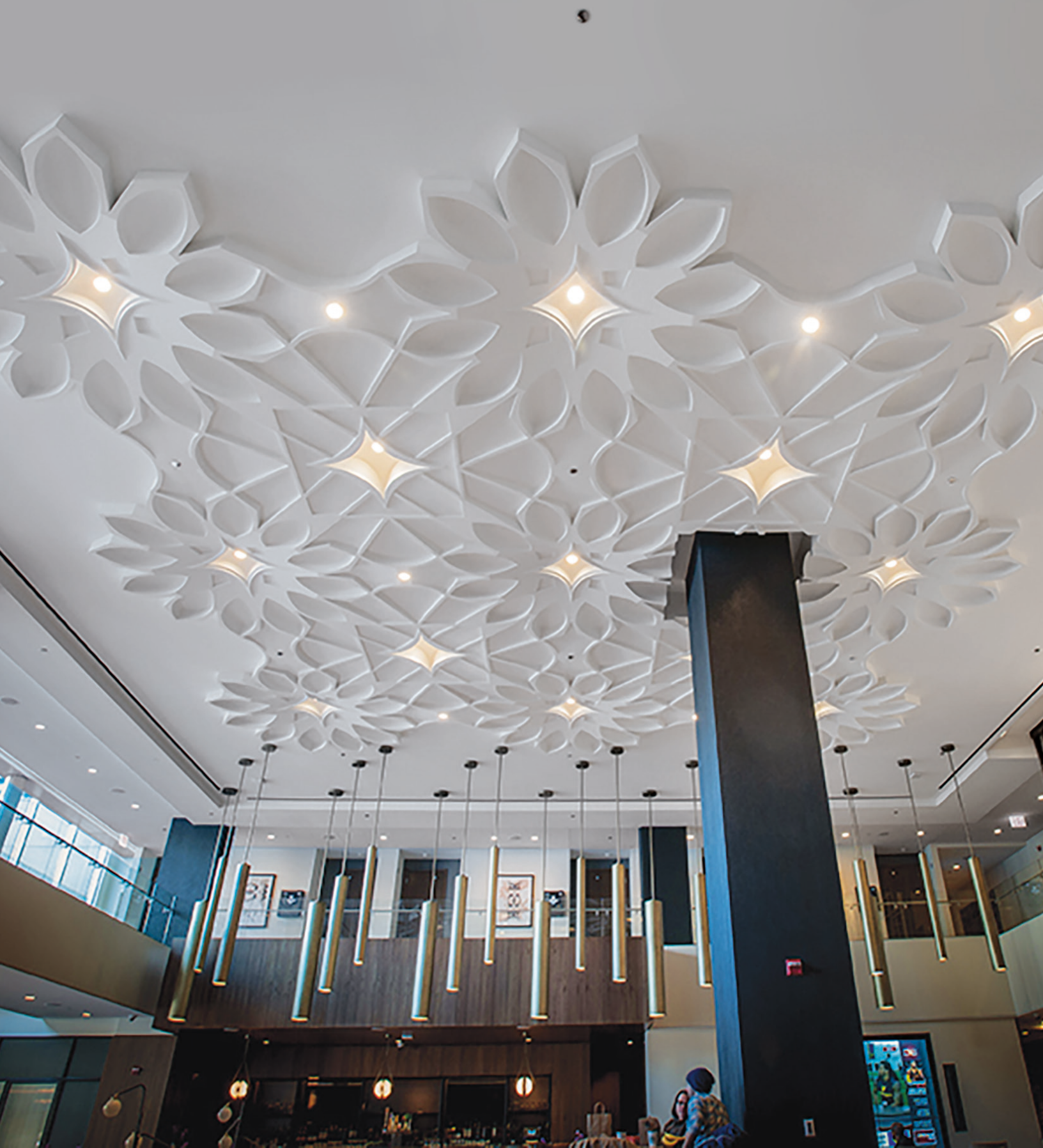
Application de plafond sur mesure en GRV; Hôtel Loews, Chicago, IL; Simone Deary Design Group
