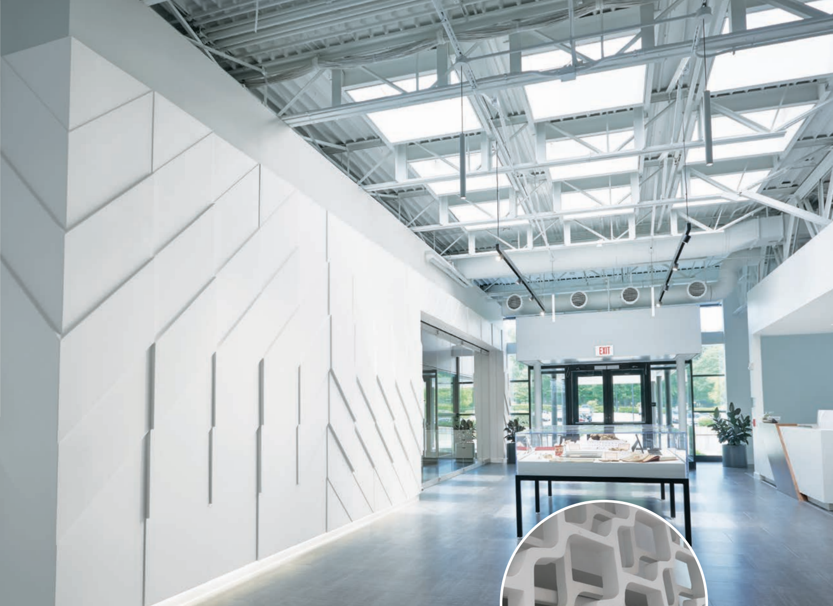
Panneaux muraux sur mesure en GRV; Hall d'entrée d'Armstrong World Industries, Lancaster, PA
